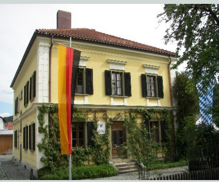
Amt für Landwirtschaft und Forsten Regensburg Dienstgebäude Forsten in Pielenhofen
